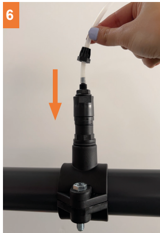
6 Insira o tubo rígido com o conector no injetor.
