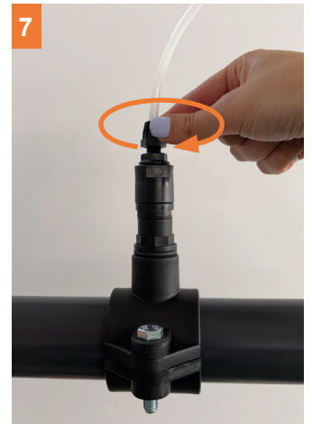
7 Parafuse o conector e verifique se está bem apertado.
