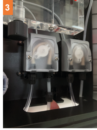
3 Empurre o tubo rígido até a união de saída da bomba
