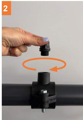
2 Parafuse o adaptador no colar.
