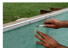
Installazione della prima guarnizione dello skimmer
