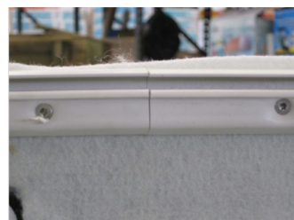
• Posizionamento dei listelli nello stesso pannello
