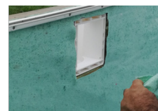
Installazione della prima guarnizione dello skimmer
