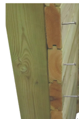
Fissare il rinforzo utilizzando una vite per ogni asse
