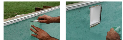
Montage der ersten Skimmerdichtung
