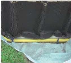
Peripherie-Entwässerung
