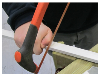
• Corte do perfil do liner
