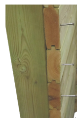
Fixe o reforço usando um parafuso em cada tábu
