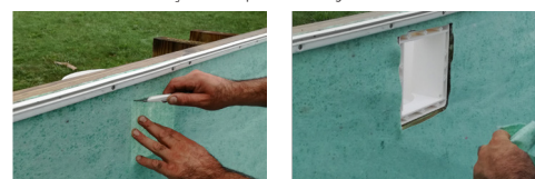
Fixação da primeira junta do skimmer
