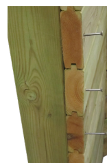
Instale el refuerzo mediante 1 tornillo por tabla
