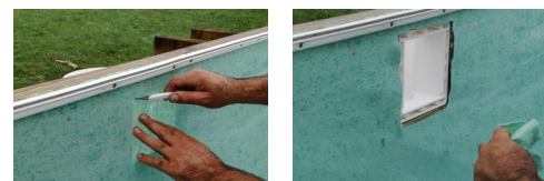
Fijación de la primera junta del skimmer
