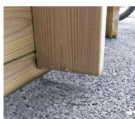
El refuerzo no toca obligatoriamente el suelo
