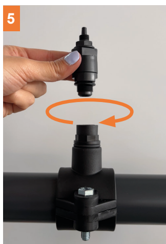
5 Enroscar el inyector al adaptador previamente colocado en el collarín.
