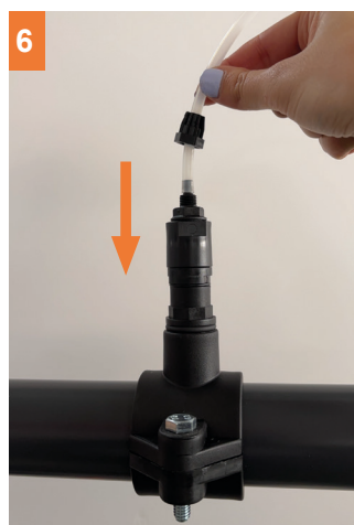
6 Introducir el tubo rígido (blanco) junto con el racor (paso 3) al inyector.
