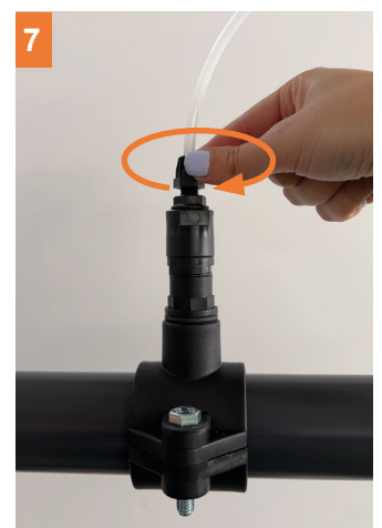
7 Enroscar y comprobar el apriete correcto del racor.
