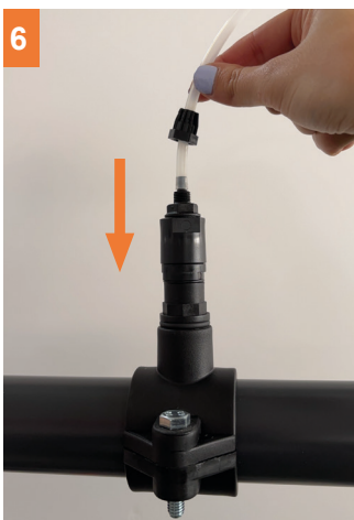
6 Duw de stijve slang met connector in de injector.
