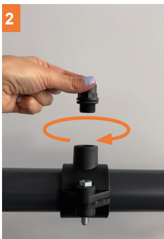
2 Schroef de adapter in het zadel.
