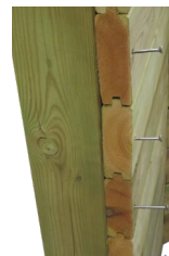
Instale el refuerzo mediante 1 tornillo por tabla
