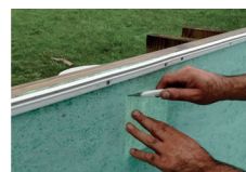
Installazione della prima guarnizione dello skimmer
