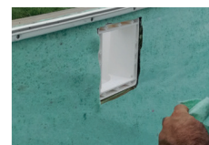
Installazione della prima guarnizione dello skimmer
