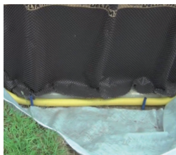
Peripheral drainage Drenaje periférico Drain périphérique Periphere Drainage Drenaggio periferico Perifere afwatering Drenagem periférica
