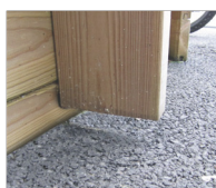
Le renfort n'est pas forcément en contact avec le sol
