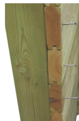
Fixez le renfort à l'aide d'une vis par lame
