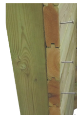
Befestigen Sie jede Verstärkung mit einer Schraube pro Brett.
