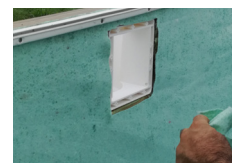
Montage der ersten Skimmerdichtung
