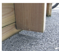
O reforço não precisa necessariamente encostar no chão
