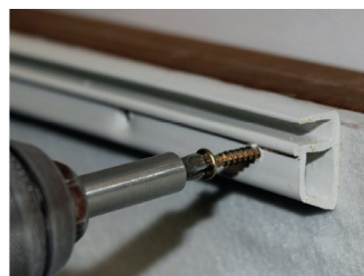
Fixação do perfil do liner
