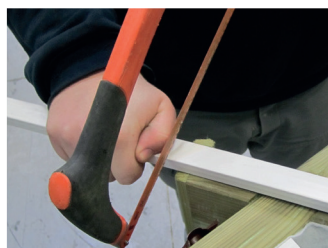
Corte do perfil do liner
