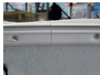
Instalação dos listões em um único painel
